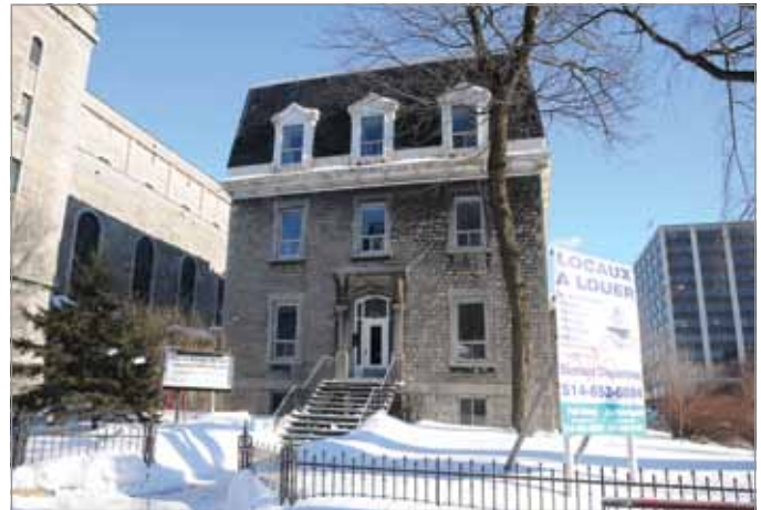
ILL. 28. PRESBYTÈRE DE L'ANCIENNE ÉGLISE SAINT-VINCENT-DE-PAUL / CENTRE PAROLE DE VIE, RUE SAINTE-CATHERINE EST. | GUILLAUME ST-JEAN, 2011.
