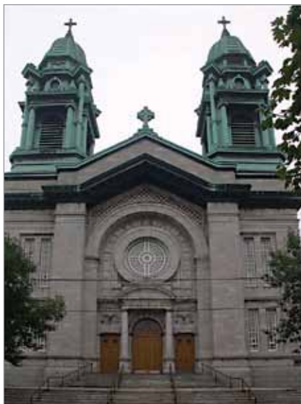
ILL. 3. ÉGLISE TRÈS-SAINTE-RÉDEMPTEUR DU QUARTIER MAISONNEUVE. CONSTRUITE EN 1927-1928 D'APRÈS LES PLANS DE DONAT-ARTHUR GASCON ET LOUIS PARENT. | CPRQ, 2003.
