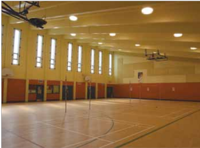
ILL. 43. ÉGLISE SAINT-BERNARD / CENTRE SPORTIF DU COLLÈGE MONT-ROYAL DE L'ARRONDISSEMENT MERCIER-HOCHÉLAGA-MAISONNEUVE. CONSTRUITE EN 1964 D'APRÈS LES PLANS DES ARCHITECTES PAUL G. GOYER ET CLAUDE GAGNIER. CONVERTIE EN 2004 EN CENTRE SPORTIF PAR CARDIN RAMIREZ, ARCHITECTES. UN ESPACE DÉDIÉ AU CULTE A ÉTÉ CONSERVÉ. | LUC NOPPEN, 2005.
